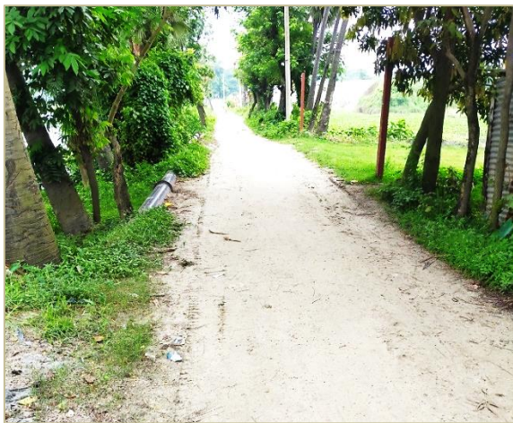
Road-1, Kaliganj Pourashava
