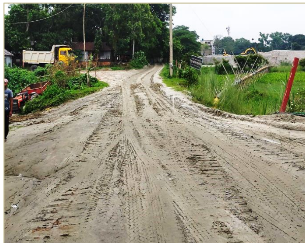
Road--1, Kaliganj Pourashava
