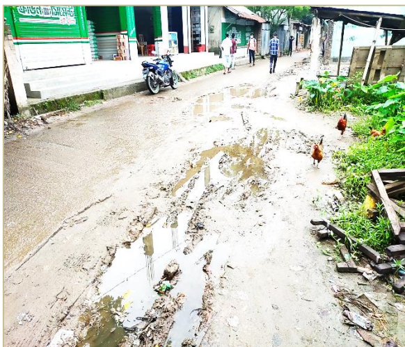
Drain -3, Kaliganj Pourashava
