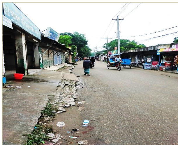
Drain- 3, Kaliganj Pourashava
